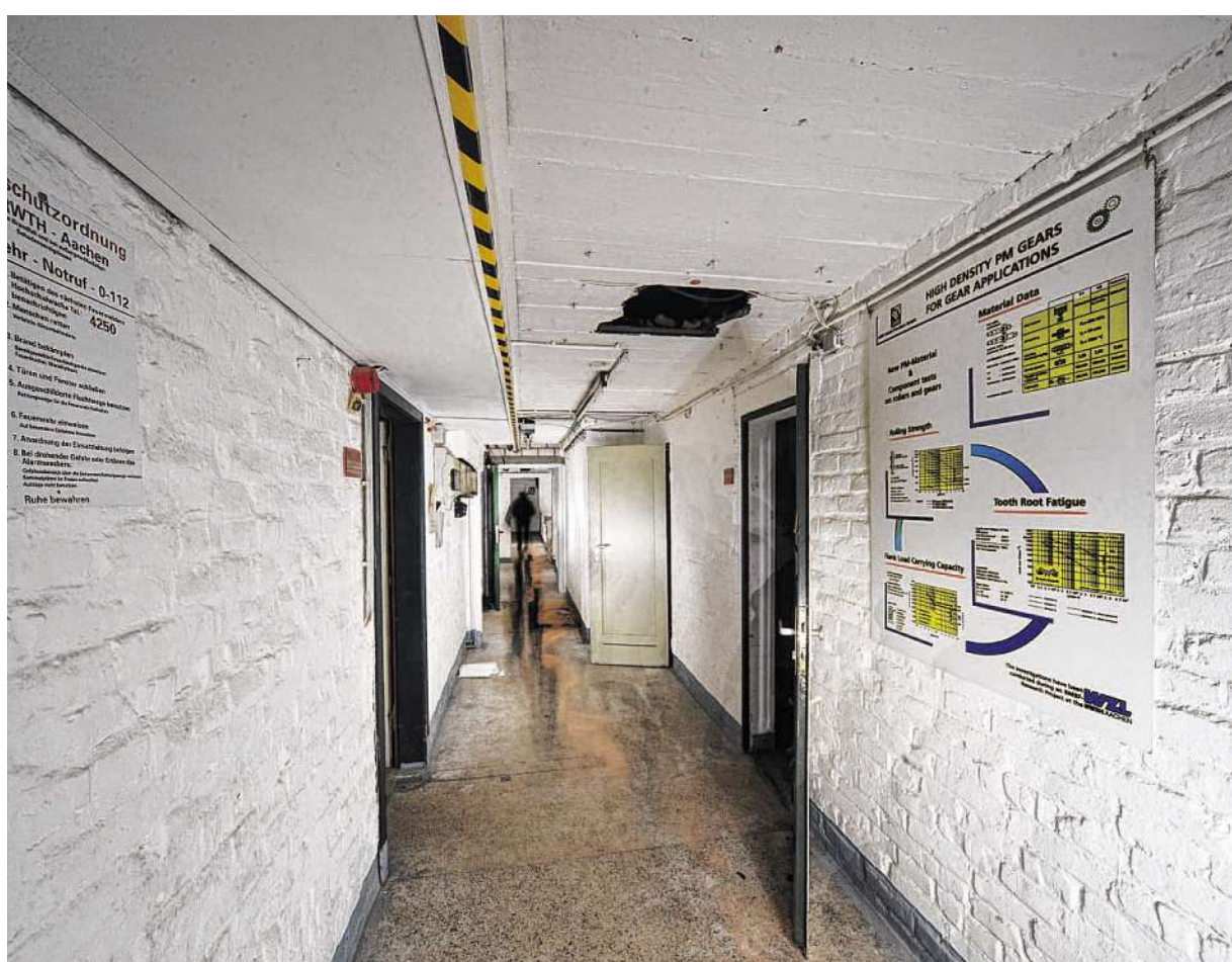
Das Werkzeugmaschinenlabor der RWTH nutzte den Bunker bis 2005 lange Jahre und hatte alle sechs Ebenen komplett, etwa für Prüfstände, umgestaltet. Das Innere wird jetzt dokumentiert. Foto: Andreas Herrmann
